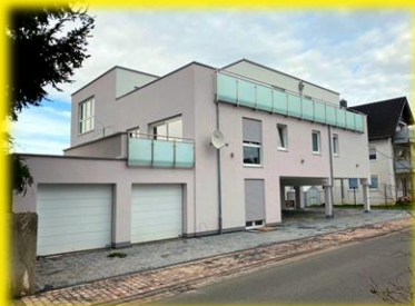
Neubau eines 4-Familien-Hauses in Babenhausen
